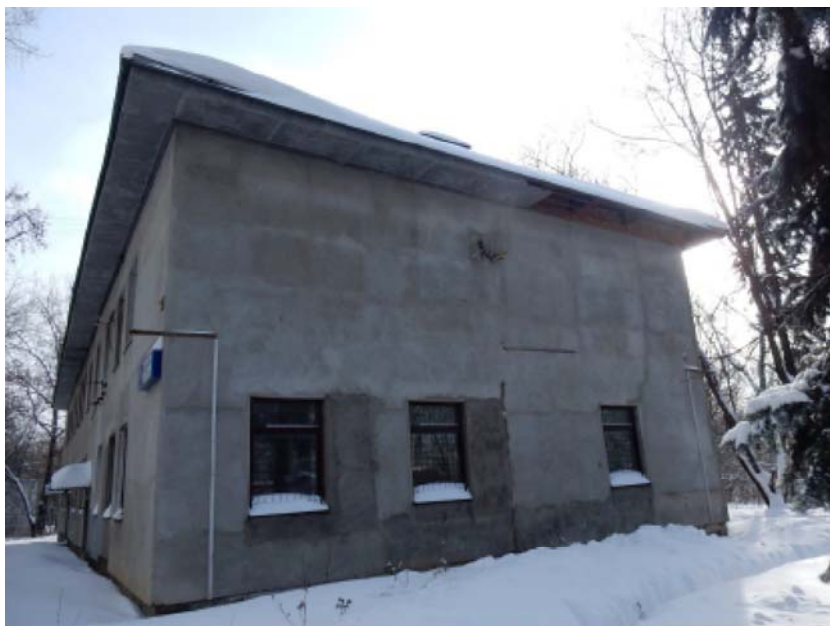
Фото 1. Общий вид фасад
