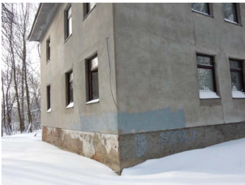
Фото 2. Общий вид фасад
