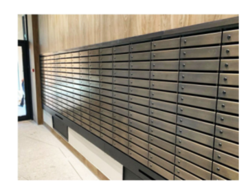
Почтовые ящики П_1.1 - П_4.6 : Материал дверки: латунь. Корпус: х/к сталь 1 мм с порошковой покраской по каталогу Ral 1002. Цифры вырезанные напрорез или лазерная гравировка. Шрифт: аналогично используемому в оборудовании ОЭ_1, ОЭ_2. Комплект: замки, ключи.
