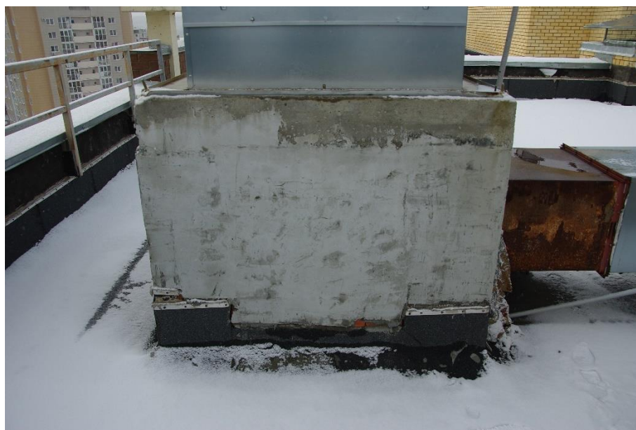
Фото 5. На основании крышного вентилятора отсутствует фартук-капельник
