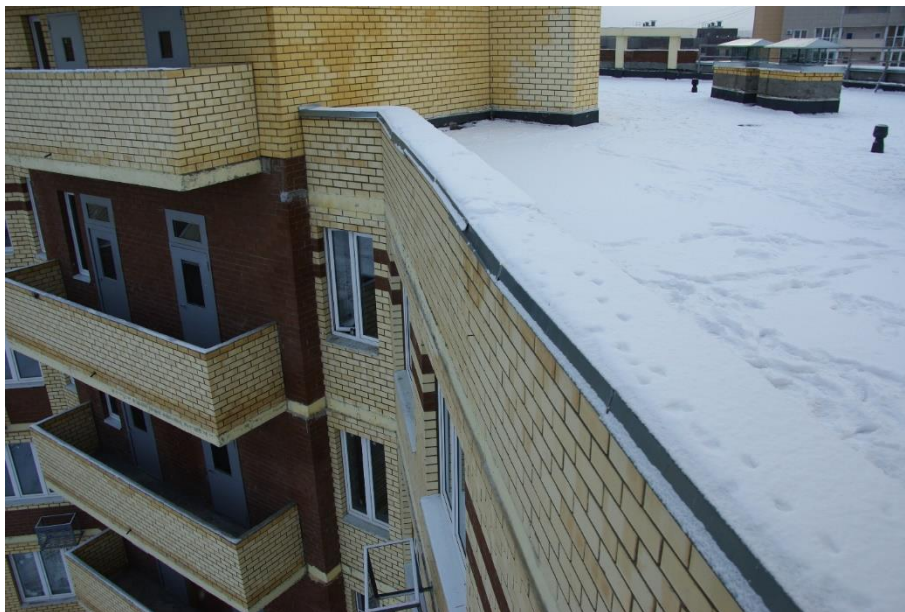
Фото 8 Отсутствует металлическое парапетное ограждение
