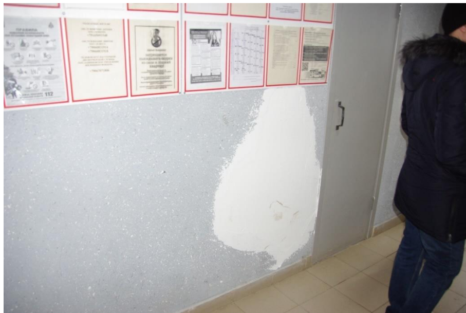
Фото 10. Повреждение отделочных покрытий стен в холле 1 этажа секции 5
