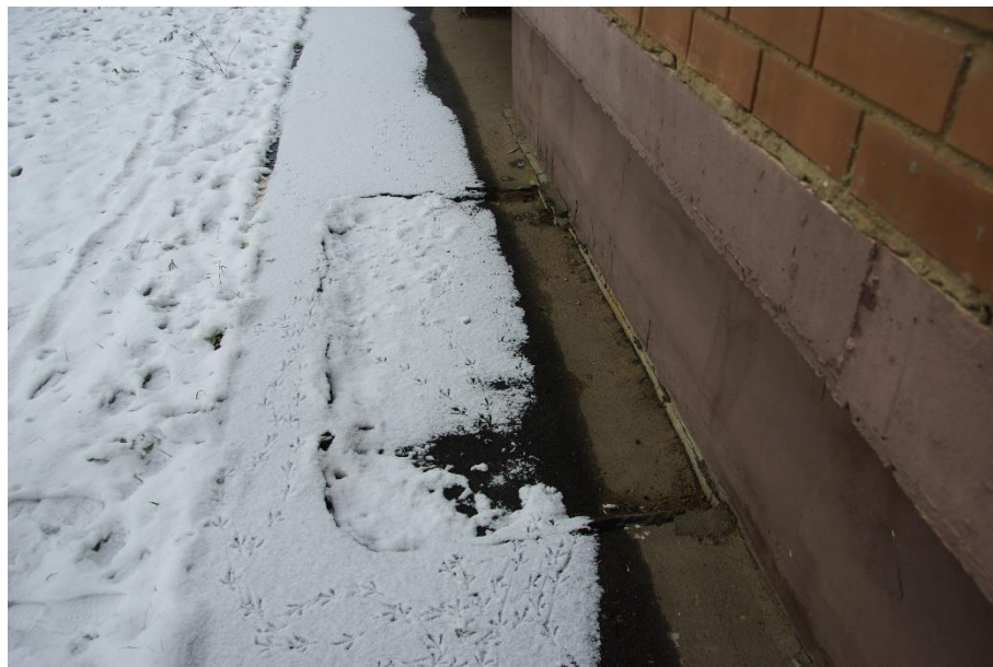
Фото 9 Проседание асфальтовой отмостки.
