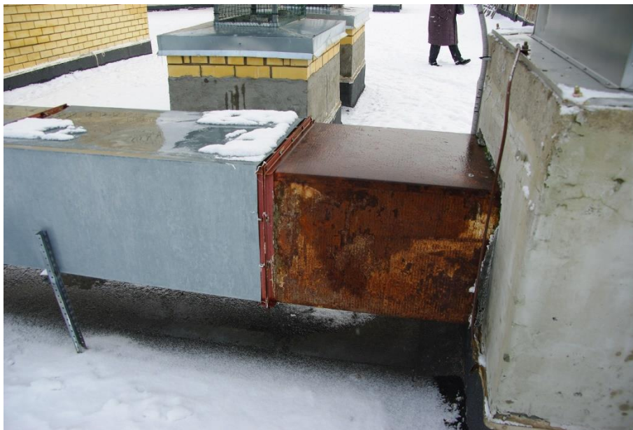
Фото 6 Вентиляционный короб подвергнут коррозии
