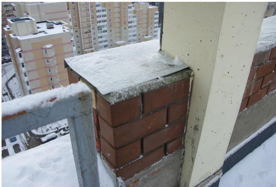
Фото 3. Отсутствует капельник парапета на внутренней поверхности стены
